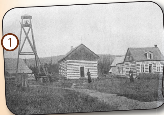
1-La première chapelle et le premier presbytère de Saint-Rémi-d'Amherst érigés en pièces sur pièces en 1883. (source archives diocèse : ph1chr23)
